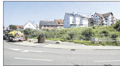
Das Gelände des ehemaligen Tanzlokals Balaton liegt seit Jahren brach – nun sollen hier 37 Wohnungen entstehen.
